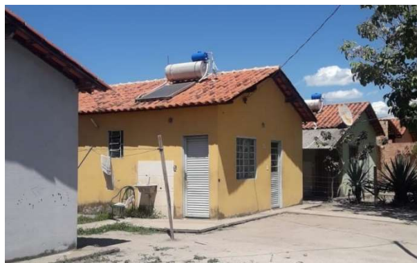
Figura 4: Residência do conjunto.
