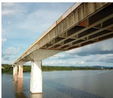
Figura 1: Ponte de Porto Nacional.
